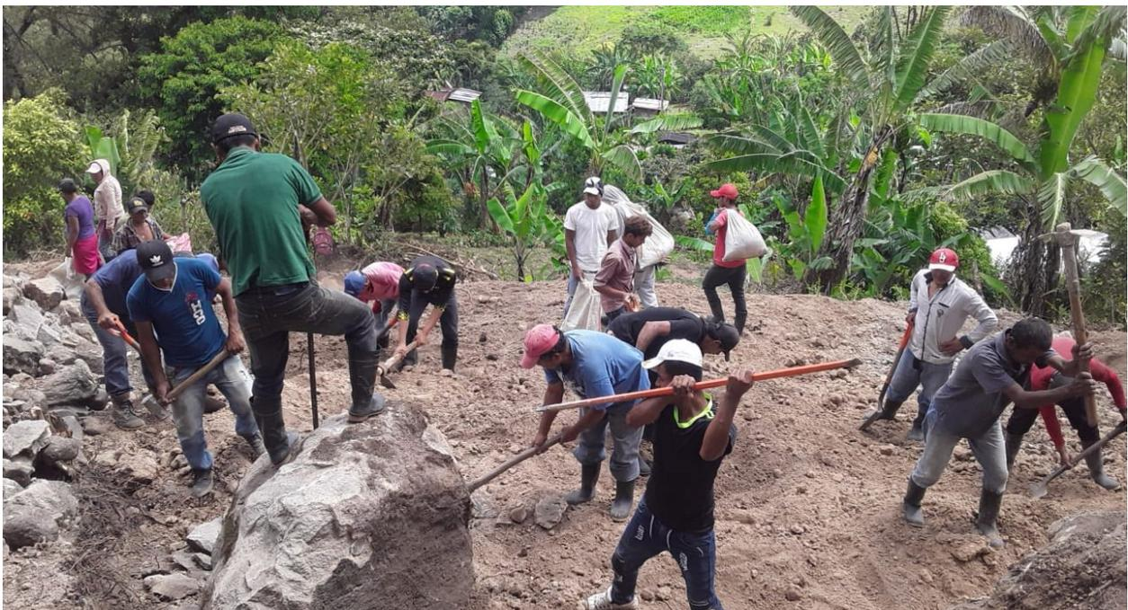
So werden die Steine für das Fundament des Wassertanks gewonnen
