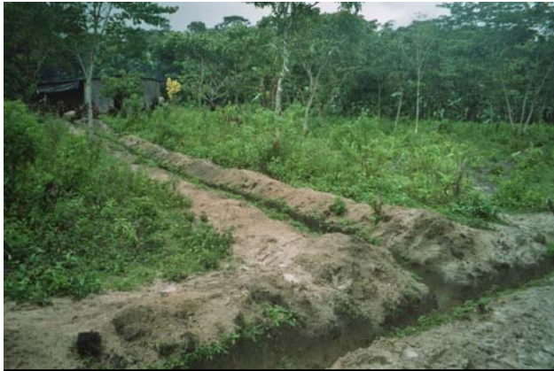
Gräben sind bis zu den Häusern bereit
