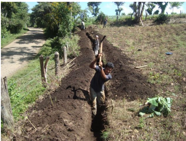
Grabarbeiten für die Leitungen
