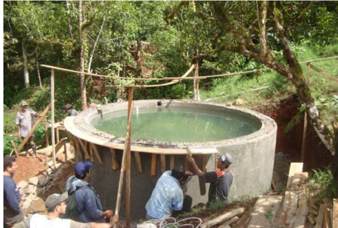
Bauarbeiten am Reservoir
