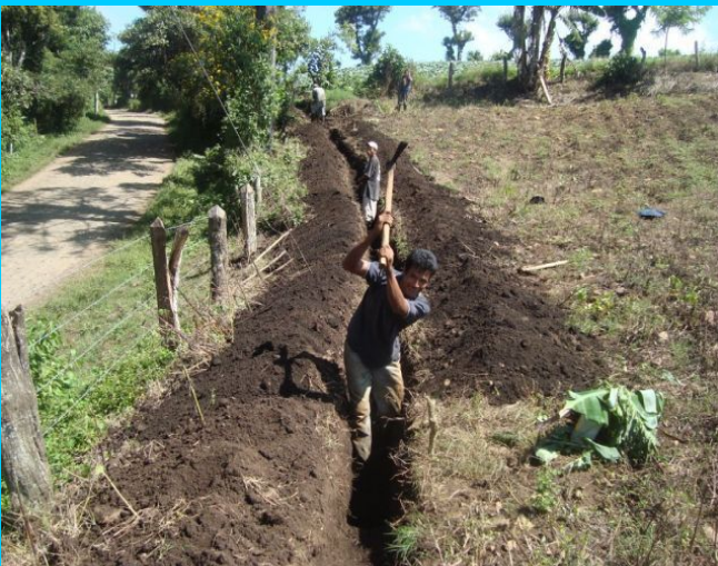
Gräben für die Leitungen
