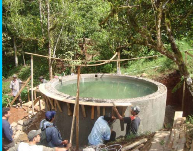
Das Reservoir wird erstellt
