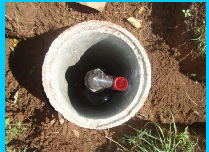
Die erste Hausinstallation ist bereit
