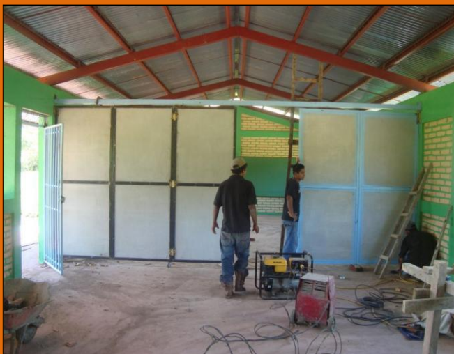
Die flexible Innenwand wird montiert
