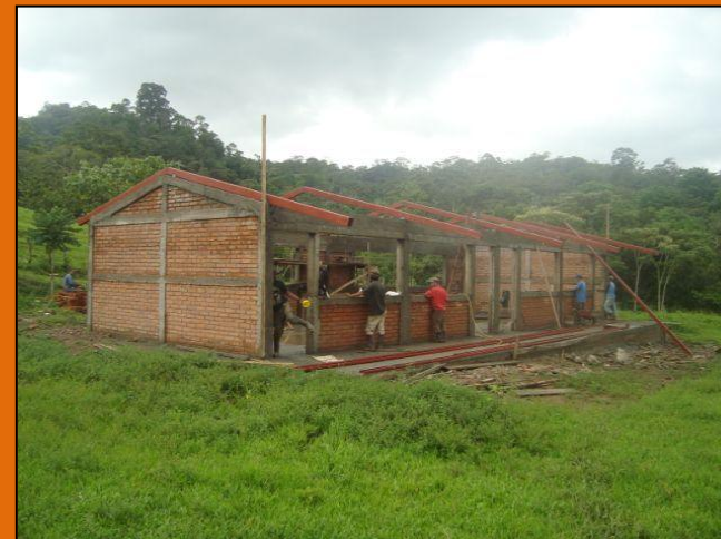
Nach kurzer Zeit stehen die Wände
