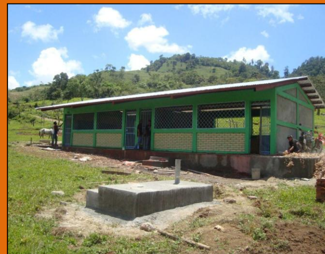
nach 4 Monaten Bauzeit
