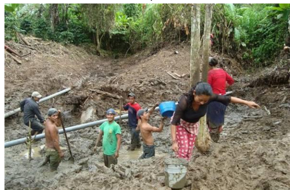
Arbeiten bei der Quellenfassung in El Dorado
