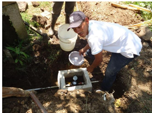
Wasseruhren werden in Sardinal eingebaut
